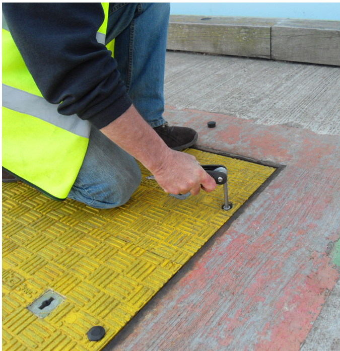
Arbetare som tar bort Fibrelite-säkringssystemet
