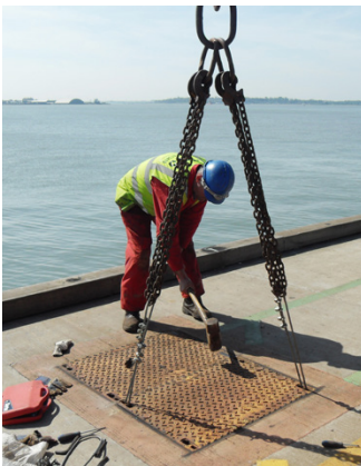
Kostsamt och tidskrävande arbete för att ta bort de tidigare monterade locken
